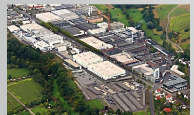
Luftaufnahme der Firmenzentrale in Heuchelheim bei Gießen
